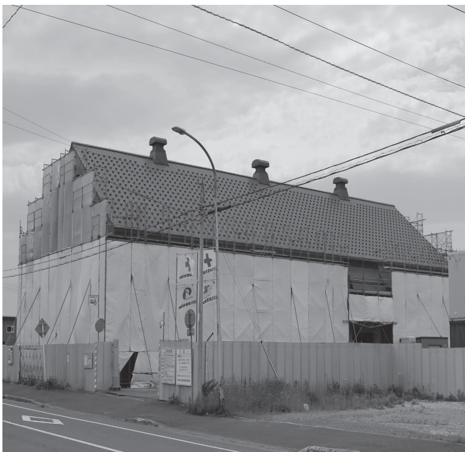
コミュニティ放送局が開設される工事中の「くりふと」
