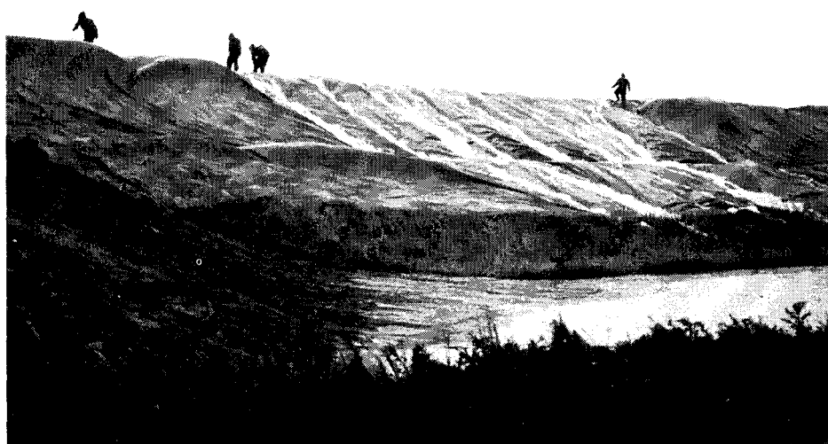
懸命に水防作業にもかかわらず、水位は上昇を続け、ついに越水が始まる 堤防を覆ったシートの上を幾筋かの水が流れ落ちる状況
