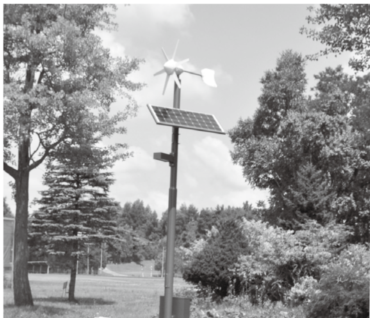
栗山中学校に設置されている 風力・太陽光ハイブリット発電街路灯
