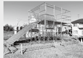
更新した訓練塔
