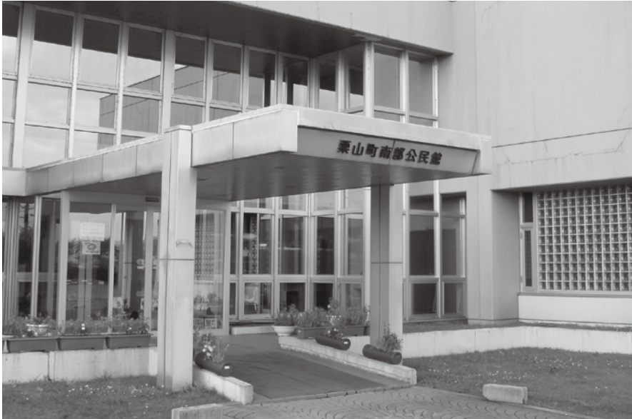
町内には老朽化が進んでいる施設が多数ある
