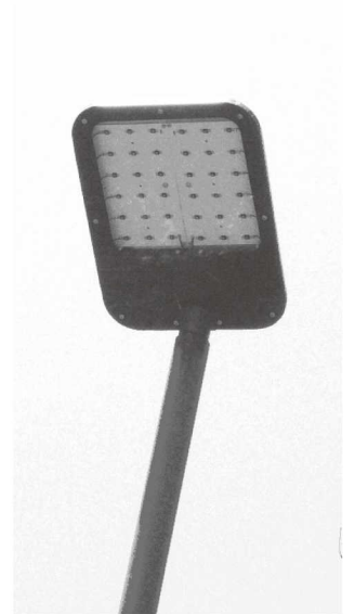
LED街路灯の照射面。黒いツブツブに見えるところがLED。
