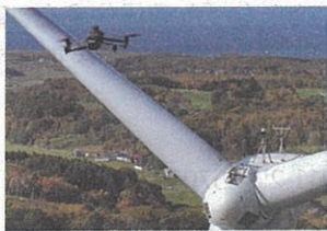
風車を点検するドローン
