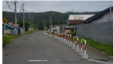
錦1号線歩道新設事業
