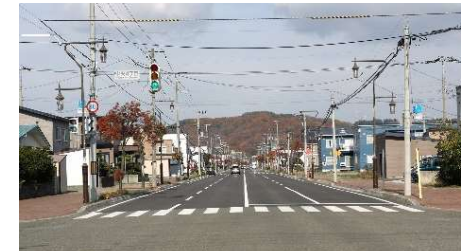
中央通り舗装補修事業 (令和6年度から4カ年)
