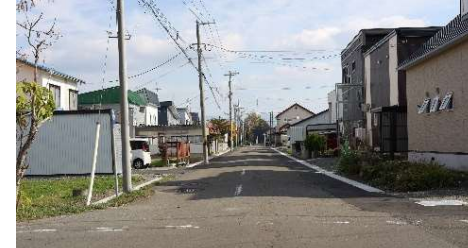
松風6線側溝改修事業 (令和6年度から2カ年)
