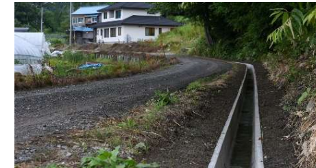
湯地・鳩山線側溝整備事業
