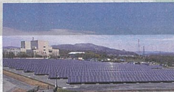
伊達ソーラー発電所(北海道電力)
