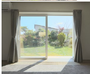
外窓交換(はつり工法)を実施
