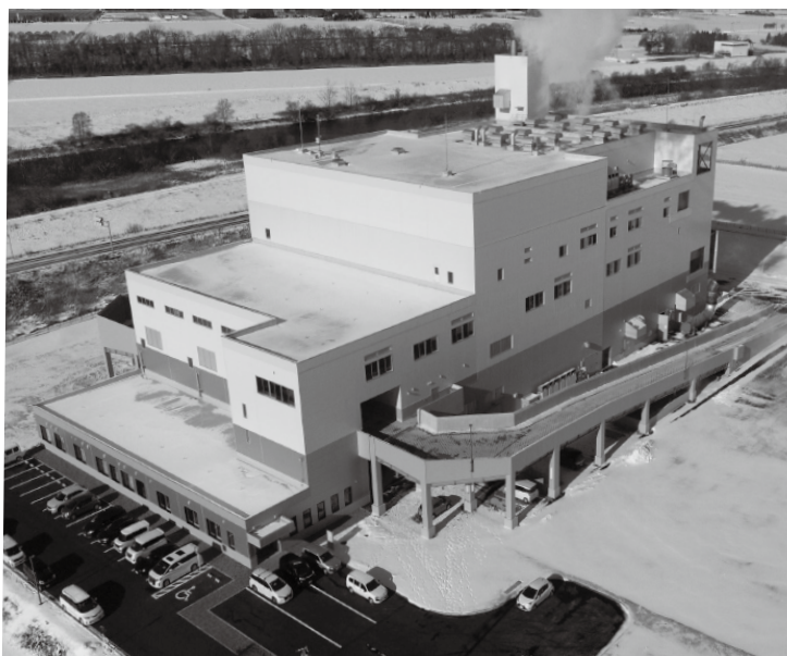
余剰電力を売電している道央廃棄物処理組合焼却施設
