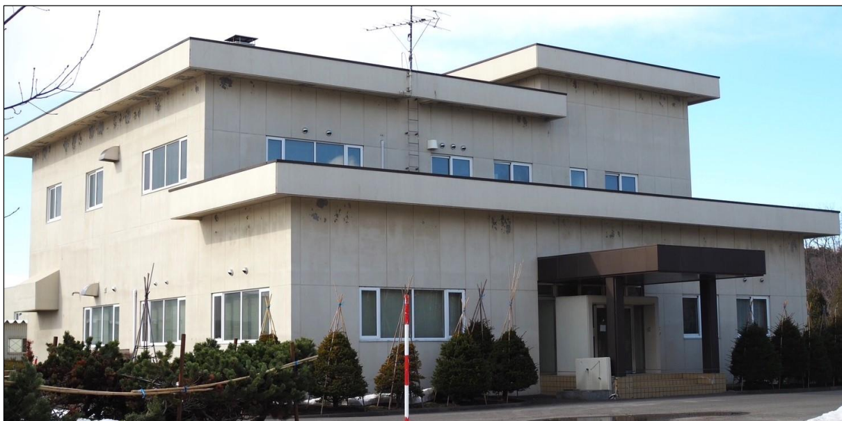
〔写真：栗山下水道管理センター〕
