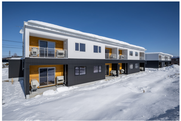
(新築した中央南団地)
