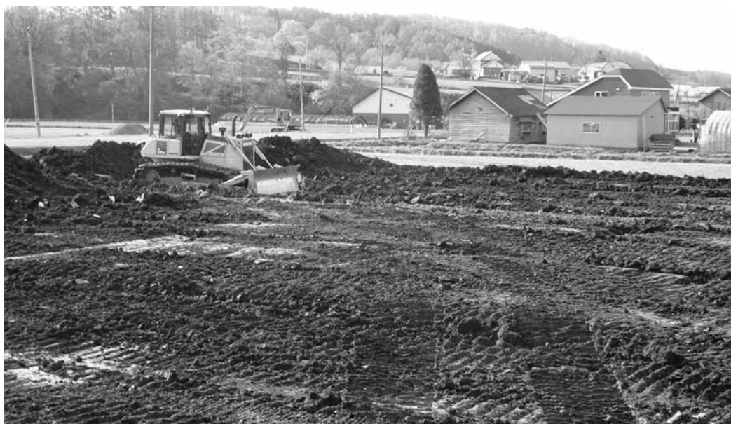
将来の地域産業を支えるための農地の基盤整備が進行中
