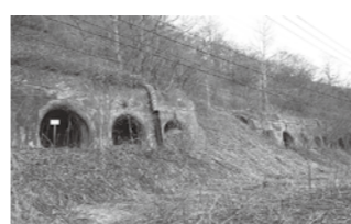
栗山トンネルの覆道部分
