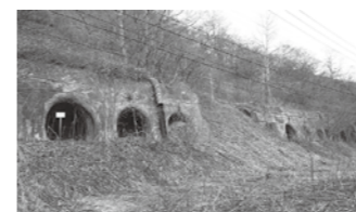
栗山トンネルの覆道部分
