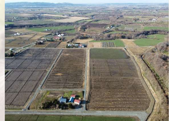
道営事業による円山地区基盤整備
