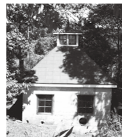
南学田の電気揚水機場
