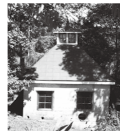
南学田の電気揚水機場
