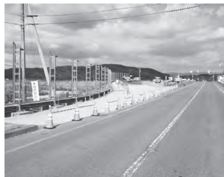
6 代目の馬追橋、仮橋工事中(令和 2 年)
