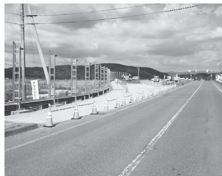
6 代目の馬追橋、仮橋工事中(令和 2 年)
