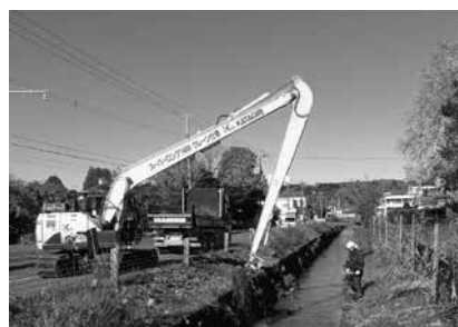
河川の土砂を取り除き、災害に備える
