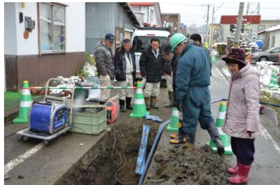
産業福祉常任委員会現地視察（水道管老朽管更新工事）
