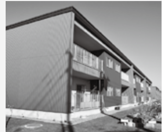
（建て替えが進む松栄団地）
