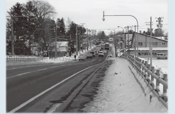
今年度から角田跨線橋の撤去工事が始まります（実施主体：国）
