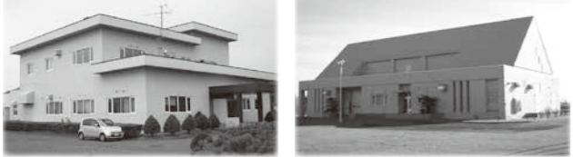
下水道管理センター
