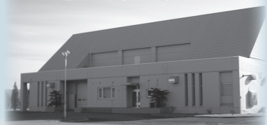
継立地区農業集落排水処理場
