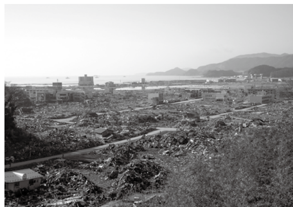
津波により被害を受けた陸前高田市
