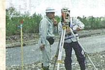
復旧工事に立ち会う様子
