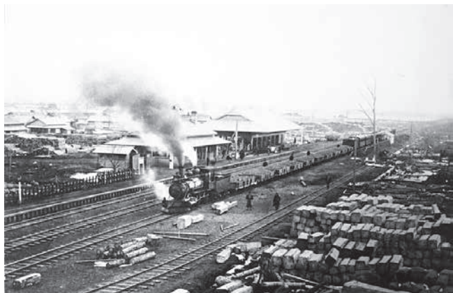
【写真】室蘭から岩見沢へ石炭を運ぶ SL (明治 44 年栗山駅構内)
