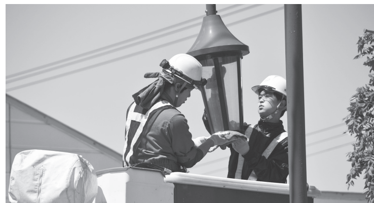
町内の街路灯を清掃する鳥山電気工事の社員
