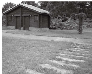
開拓記念公園内の破損した枕木は全て撤去しました。
