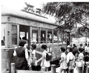
角田炭鉱専用鉄道の通学風景 (昭和40年)
