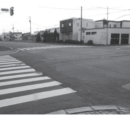
道路補修した南大通り交差点
