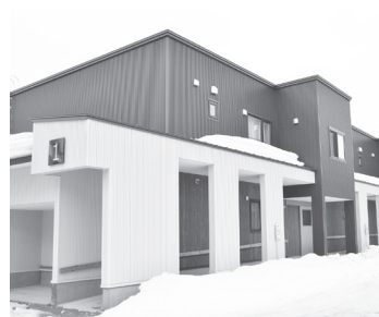
新しくなった中央団地
