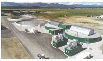
有限会社ドリームヒルのバイオガスプラント
