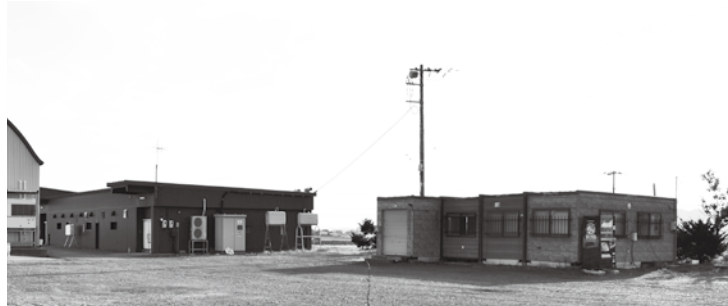
対象の設備は、すでに新事業者により活用が開始されている
