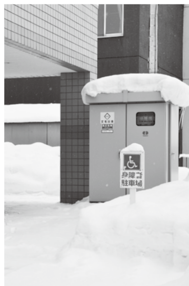
駐車スペースには看板が設置されている
