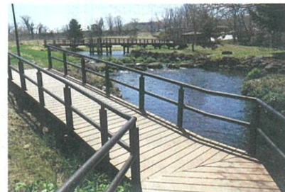
整備したふきだし公園の園路
