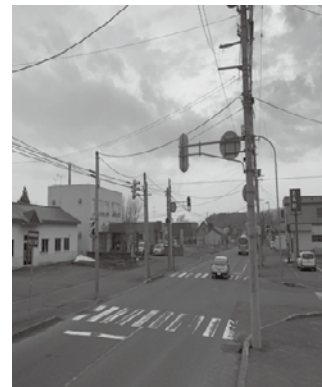
防犯カメラ設置予定箇所（継立）
