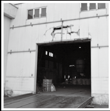
外壁に亀裂がはいった リサイクルセンター（共和）
