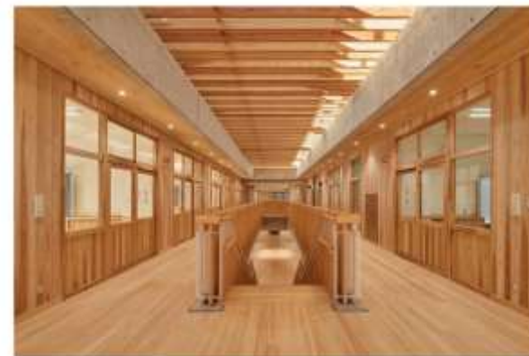
吉野スギ、吉野ヒノキにより内装木質化された床・壁・天井
