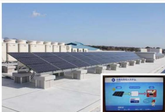
屋上に20kWの太陽光発電パネルを設置
